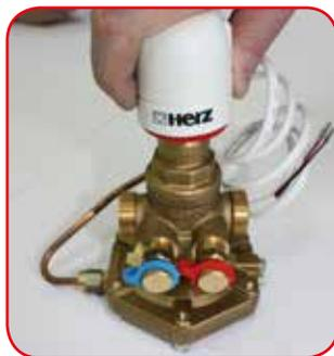
Контрольные измерения объемного расхода можно сделать с помощью измерительных клапанов, установленных непосредственно на регуляторе расхода, при использовании электронного измерительного прибора.
