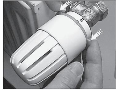
Фіксуюча втулка ③ тепер розблокована, і її можна переміщати до кріпильної гайки; на маховику стає видно позначки налаштування. Ключ для розблокування можна зняти.
