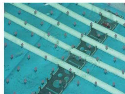
Интервал размещения труб в краевой зоне теплого пола
