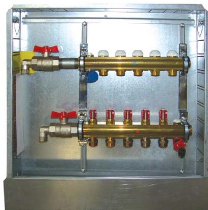
Узел распределения для радиаторов и теплых полов. Количество отводов для присоединений труб: 3 - 7.
