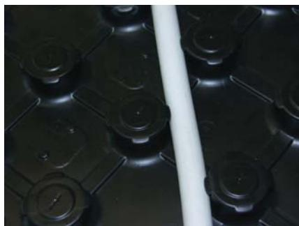
Трубы отопления в соответствии с желаемым интервалом между ними укладываются в маты с бобышками.
